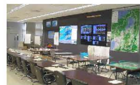
指令室(淀川ダム統合管理事務所)
