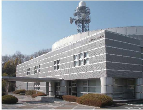
淀川ダム統合管理事務所
