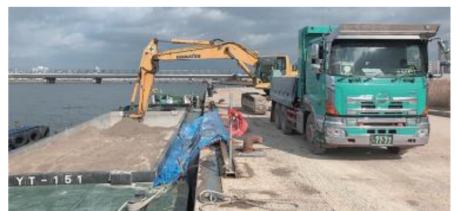
海老江緊急用船着場での河川工事
