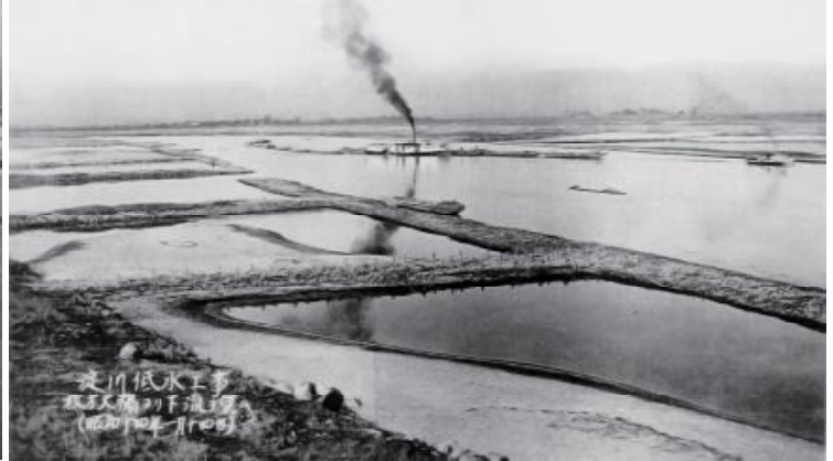
水制工による淀川低水工事
