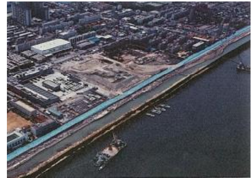
船舶を利用した復旧工事
