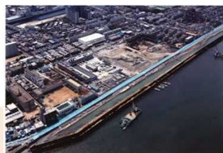
阪神淡路大震災における舟運を活用した堤防復旧
