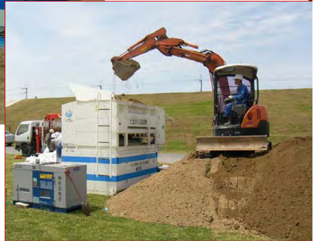
バックホウによるホッパへの土砂投入状況
