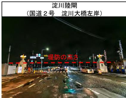
橋の高さが堤防の高さよりも低く、堤防が切り欠いた状態となっています。平常時は、車が通行できるように防潮鉄扉は開放されています。
