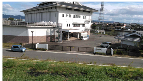
巨椋池排水機場
