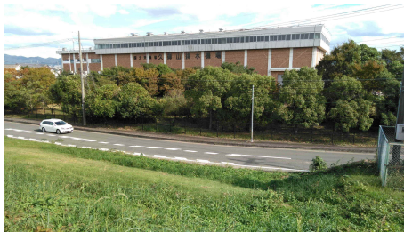
国土交通省久御山排水機場
