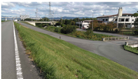
左岸八幡城南センター付近 1
