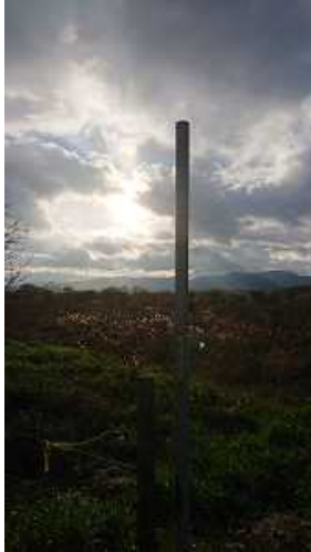
←西大橋から約440mの河川敷道沿いに看板と思われる物の破損がありました。
