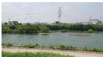
放流後右岸より
