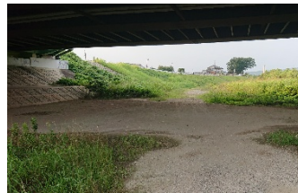
隠元橋左岸の橋下の様子
