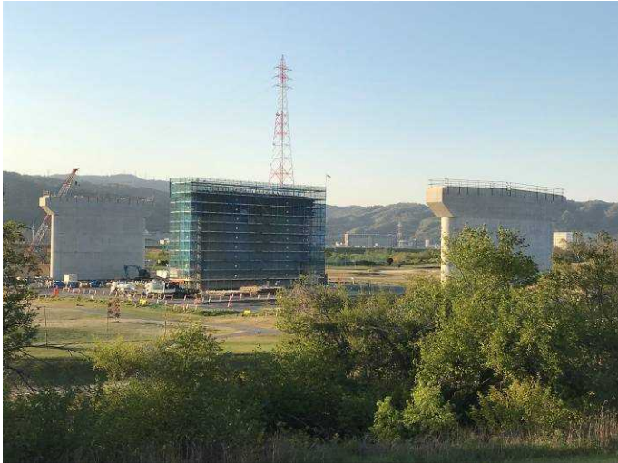
図：新名神高速道路の工事
