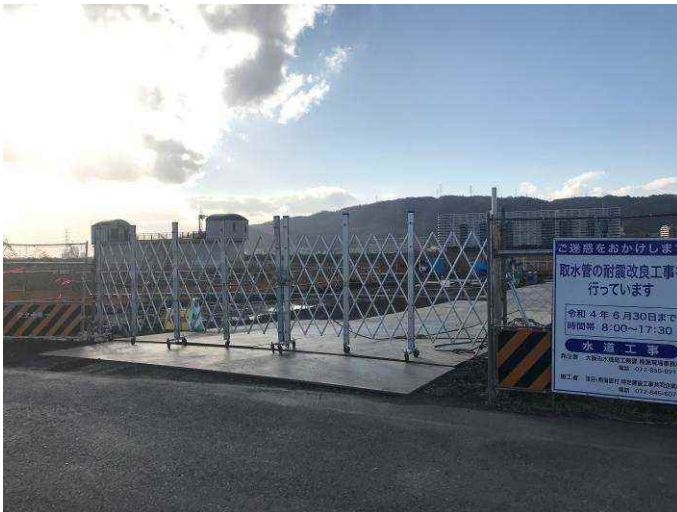
図：取水管の耐水工事
