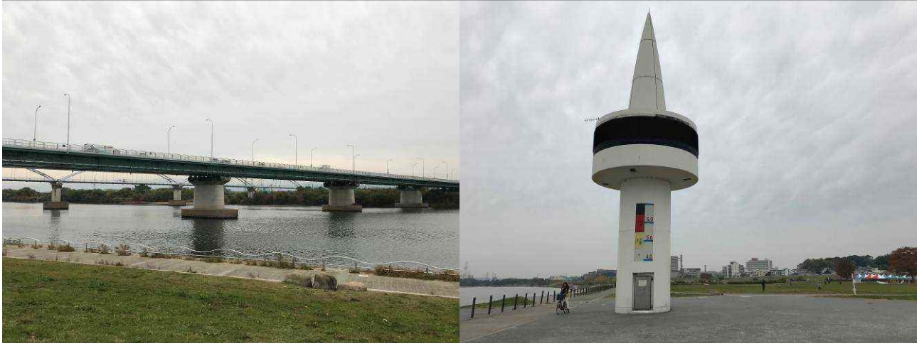
図：枚方大橋と水位観測所
