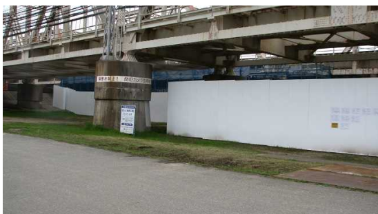
24 JR東海道本線上淀橋梁工事
