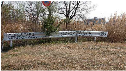
⑯ 阪急電車橋脚から上流 堤防側 草地
