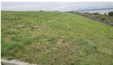
⑤区間の綺麗に刈りこまれた堤防
