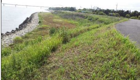
⑦区間の堤防
