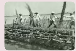
粗朶沈床を埋めこむ様子 (昭和32年撮影)
