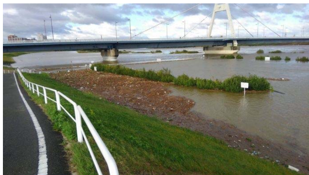
水位上昇し、公園が冠水(太子橋地区)
