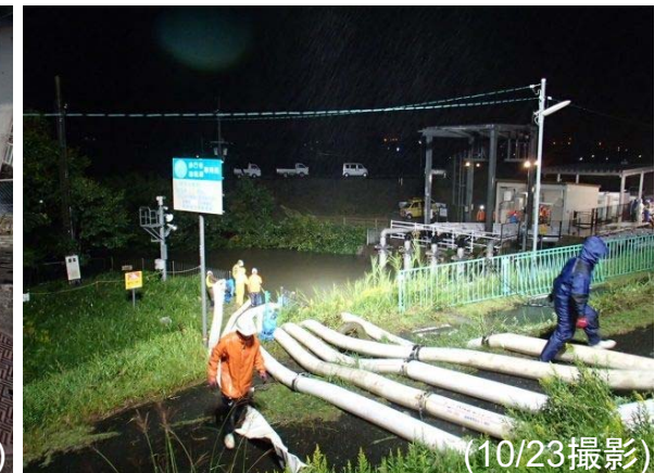
木津合同樋門
