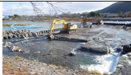
6号井堰撤去前(平成28年12月)
