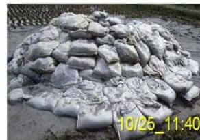
水防活動による釜段工の実施状況
