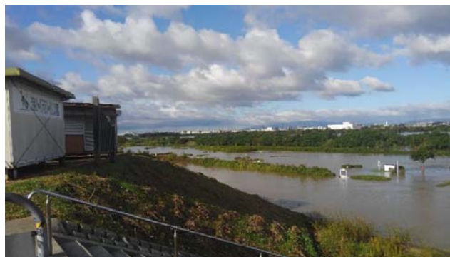
公園施設撤去、公園の冠水(仁和寺野草地区)
