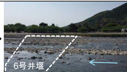
6号井堰撤去後(平成29年5月)
