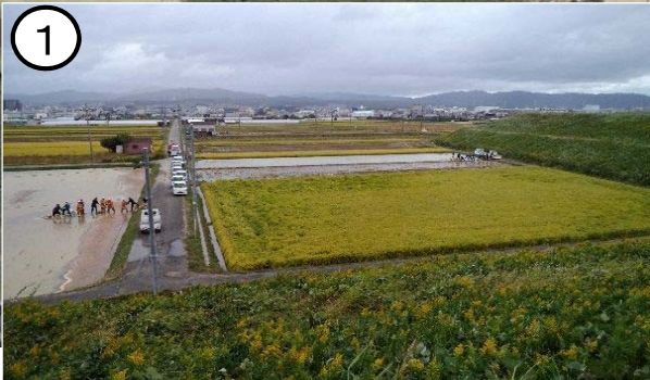
漏水状況全景
