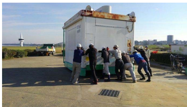
管理所の復旧状況(枚方地区)
