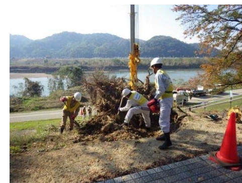
倒木した桜の木の撤去状況(背割堤地区)
