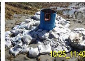
水防活動による釜段工の実施状況
