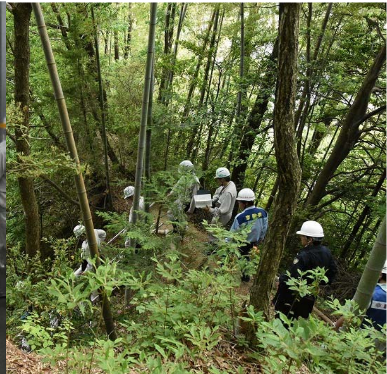
▲地すべり箇所を点検
