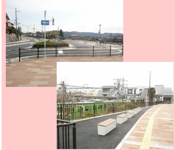
JR長池駅北側広場
