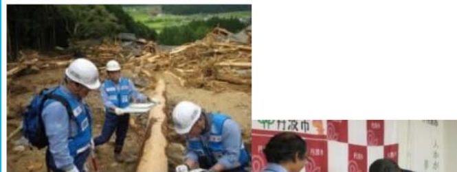
土木研究所現地調査
