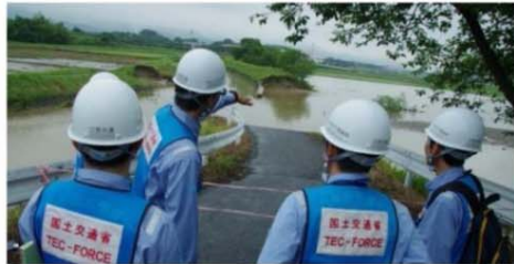
▲ 河川堤防の被災調査
