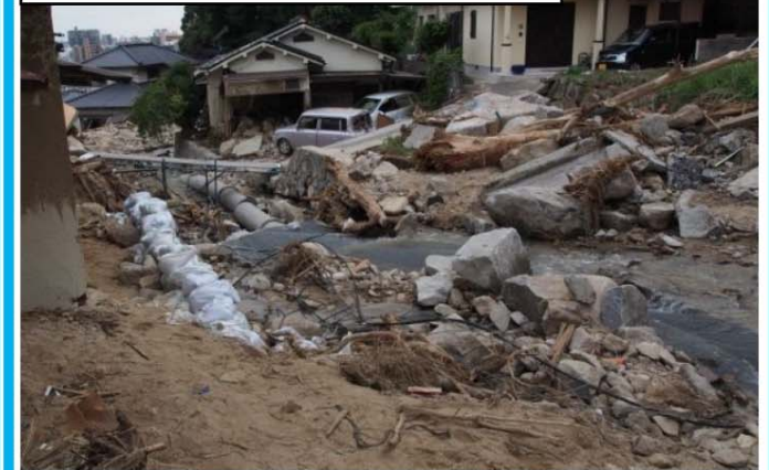
道路啓開箇所における現場監督状況
