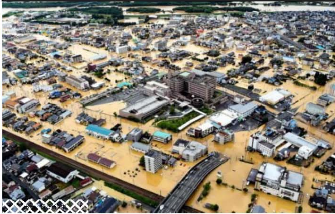
道路・河川等の被災状況調査
