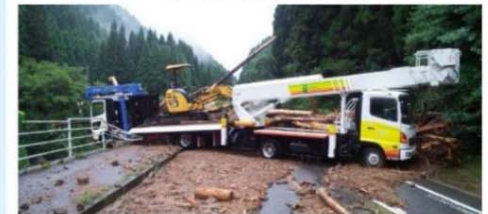
▲ 道路の啓開作業
