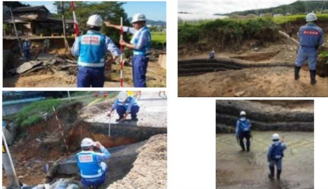
道路の状況調査
