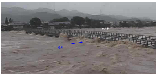
渡月橋の橋面を乗り越える洪水
