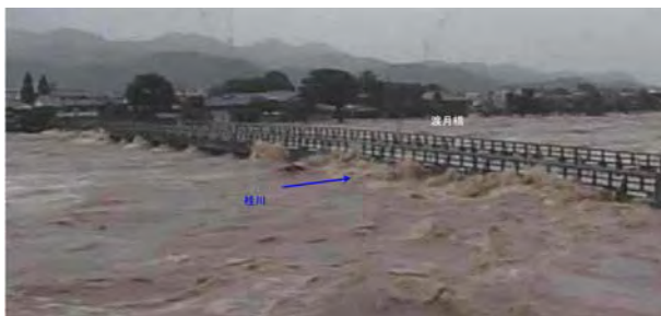
渡月橋の橋面を乗り越える洪水
