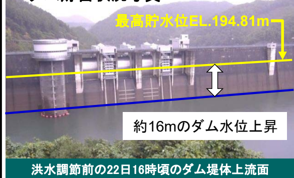
ダム貯留状況写真
