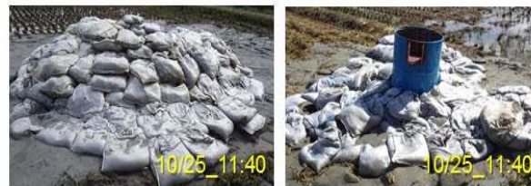
水防活動による釜段工の実施状況
