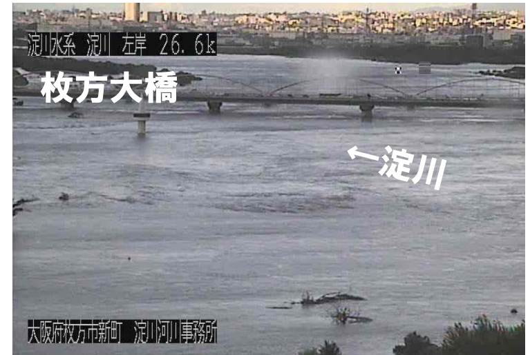
平成29年10月23日 7時00分 水位: 3.30m (枚方水位観測所)
