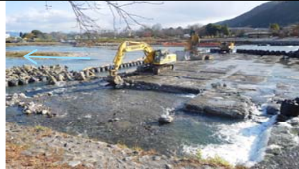
6号井堰撤去前(平成28年12月)
