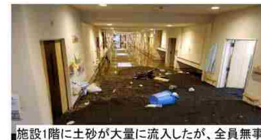
施設1階に土砂が大量に流入したが、全員無事 令和元年東日本台風 静岡県小山町における特別養護老人ホームの状況
