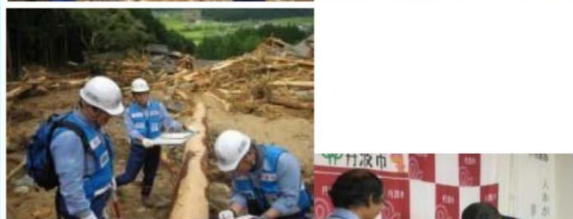
土木研究所現地調査
