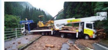
▲ 道路の啓開作業
