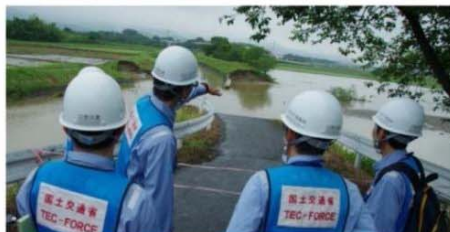
▲ 河川堤防の被災調査
