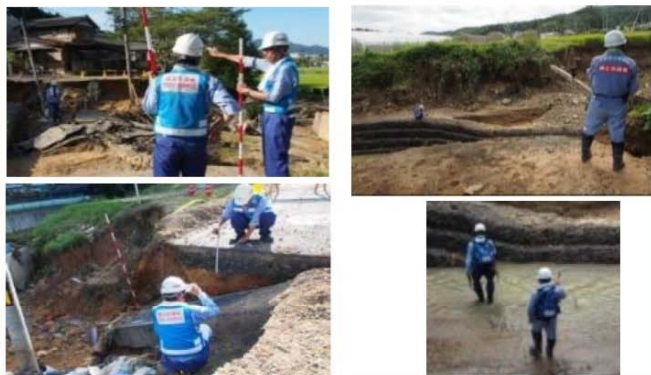
道路の状況調査
