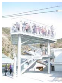
○避難タワーの設置
