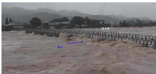
渡月橋の橋面を乗り越える洪水
