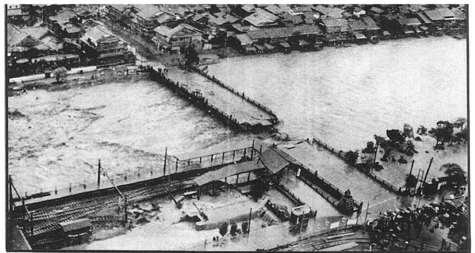
↑ 厳しい浸水により三条大橋流失 さんじょうおおはし
