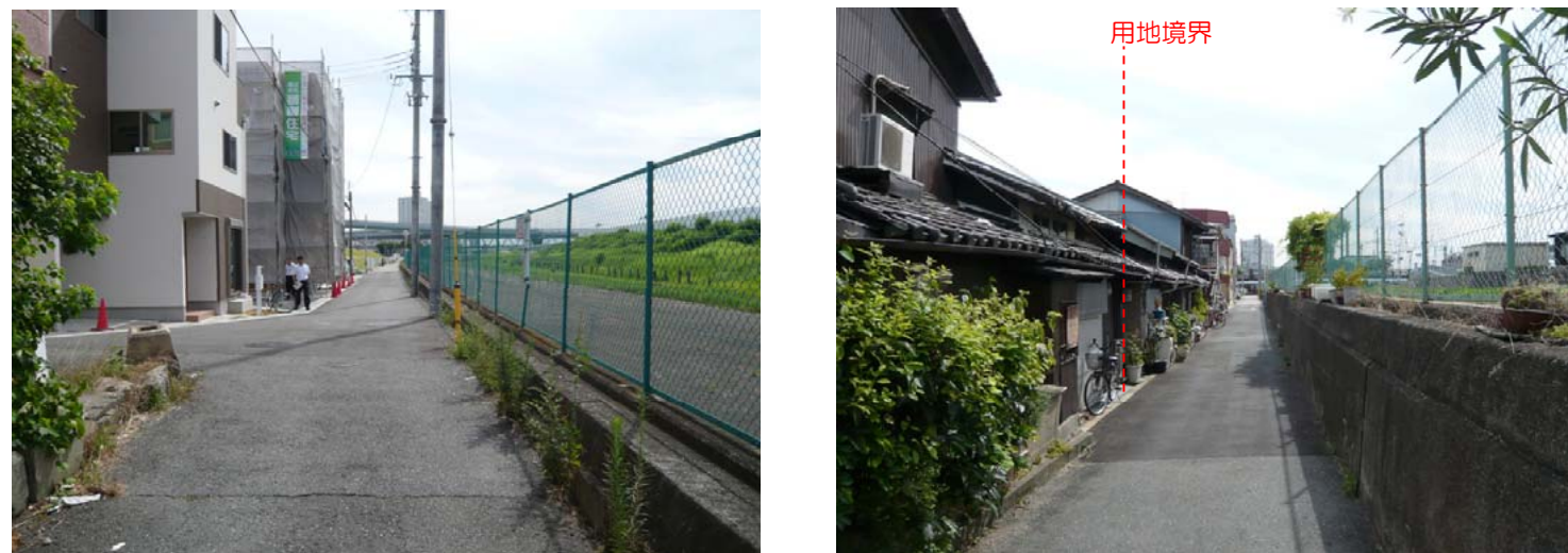
図5.1.1 検討断面箇所付近の現地状況
