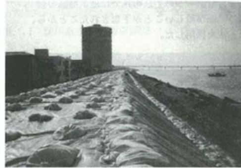
写真5.3.1 第一次緊急復旧工事
