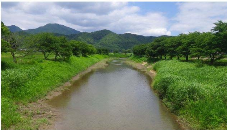
武庫川水系武庫川(兵庫県篠山市)
