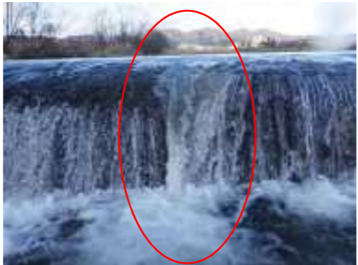
桂川 5号井堰切り欠き改良完成写真
