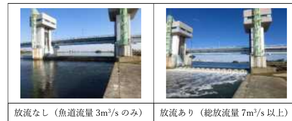
図 1.9 淀川大堰の調節ゲートからの放流状況
