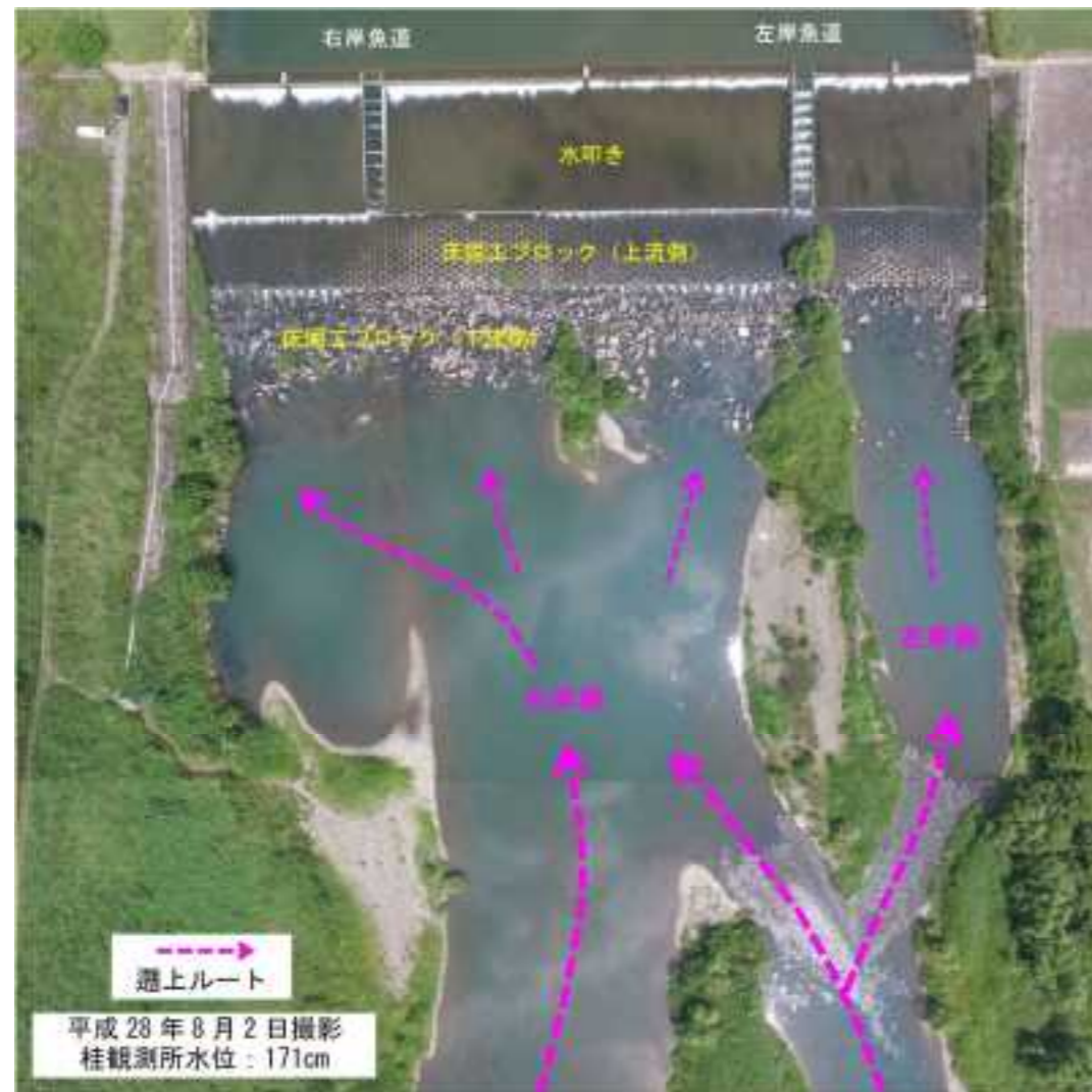
図 4.7 3号井堰周辺までの遡上ルート
