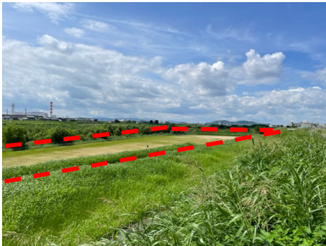
⑤右岸側から下流を望む
