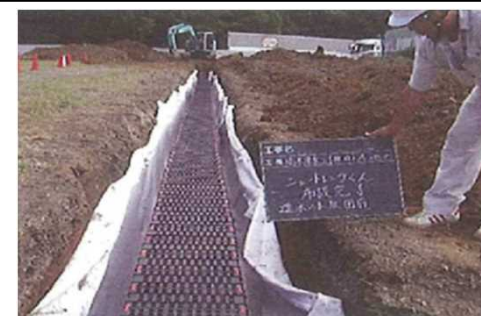
浸透トレンチ
