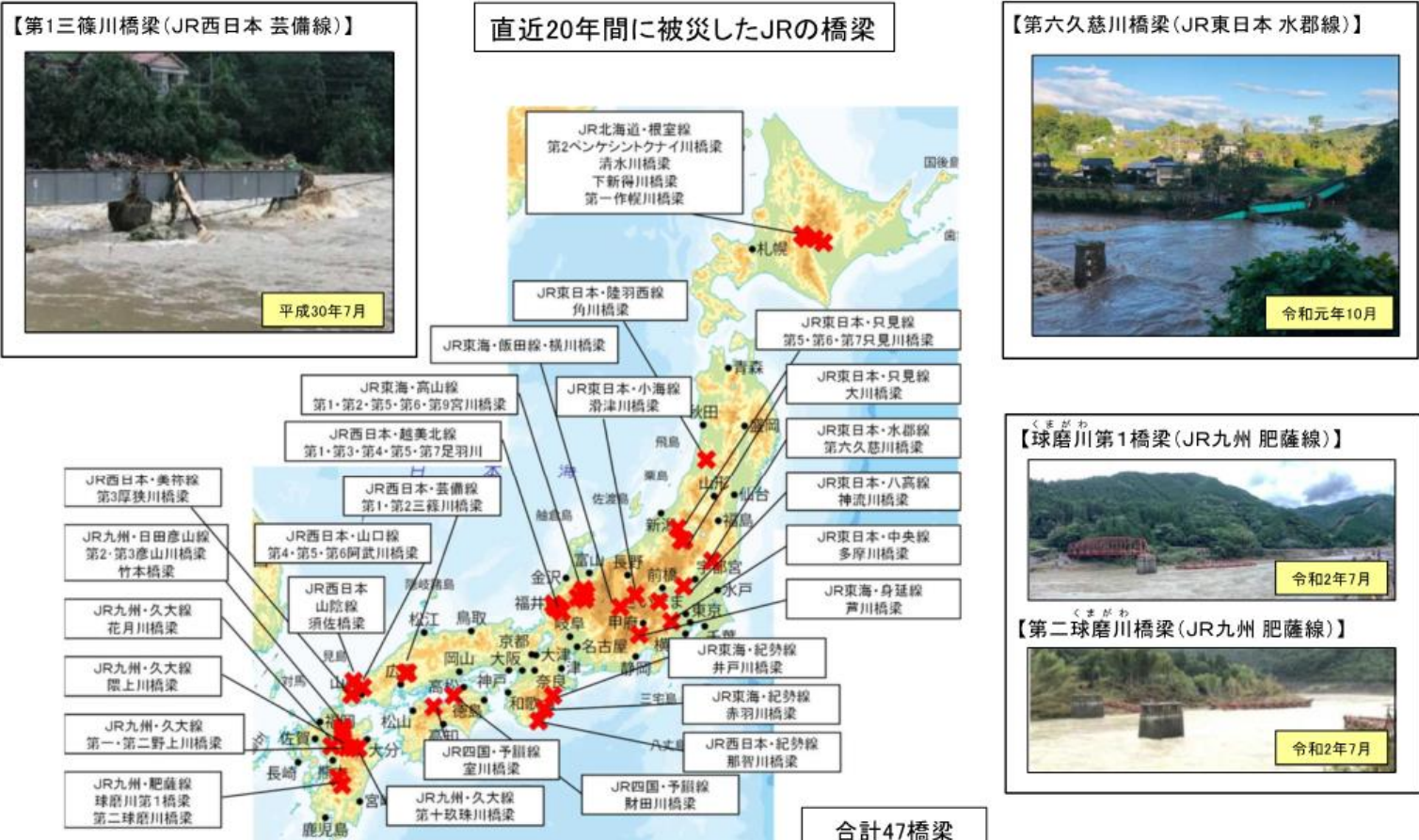
JR河川橋梁対策検討会資料より抜粋
