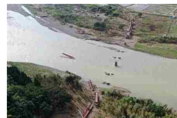
くま川鉄道 球磨川第4橋梁 橋梁流失 (熊本県球磨郡相良村-錦町)
