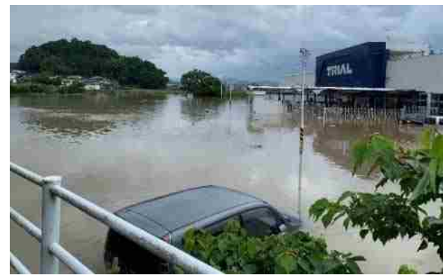
筑後川水系筑後川 (福岡県日田市)
