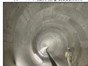
雨水貯留管内部 (仕上がり内径φ5,250mm)
