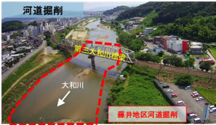
河道掘削(藤井地区)
