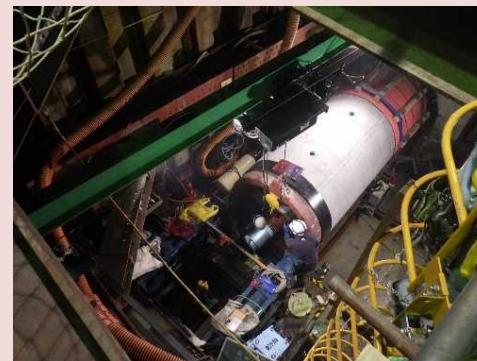
雨水管の施工状況
