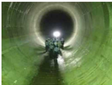
雨水貯留管の整備
