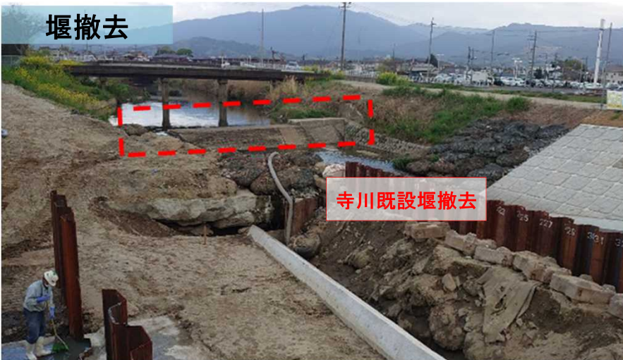
寺川堰撤去(桜井市大福工区)
