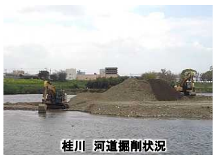
桂川、木津川 河道掘削
