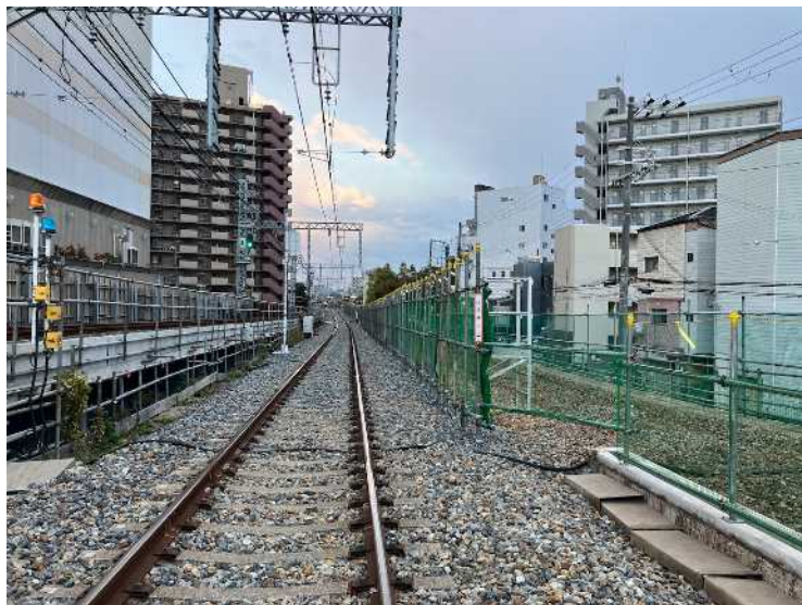
①計画線構築準備工（工事用限界柵設置）
