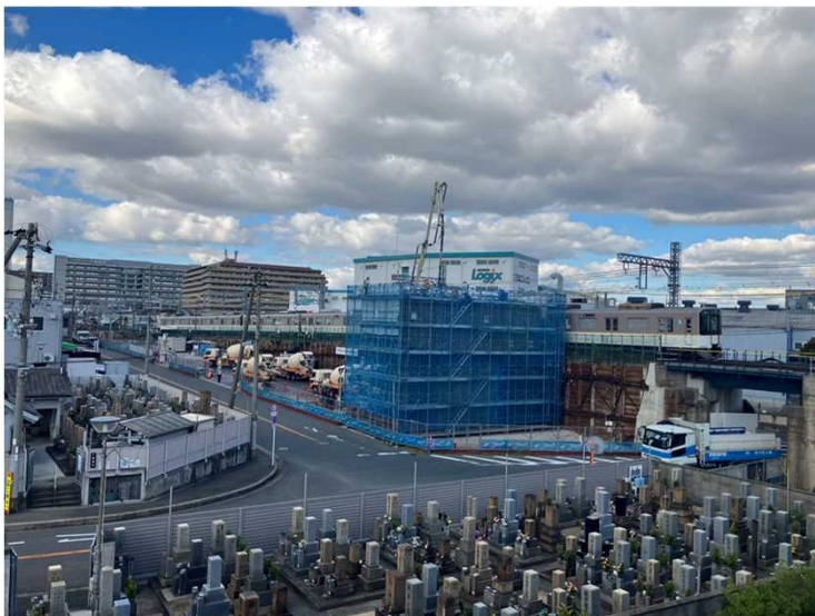
① P46梁構築工（梁構築状況）
