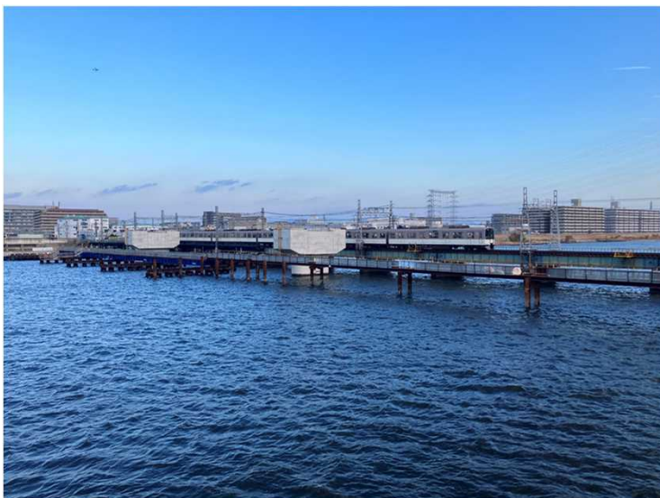
③ P50梁構築工（配管橋設置完了）
