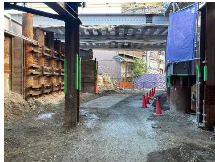
②既設橋台撤去工
