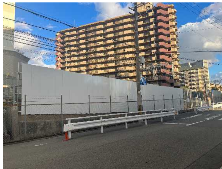
②保安柵設置工
