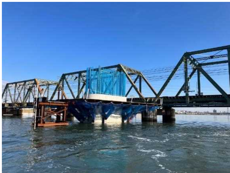
① P51鋼管矢板井筒基礎工（梁構築）
