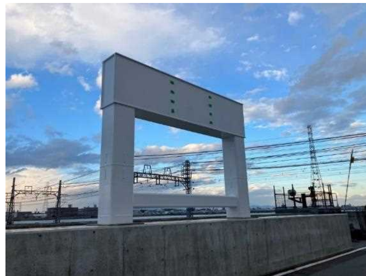
② 桁下防護工（桁架設）
