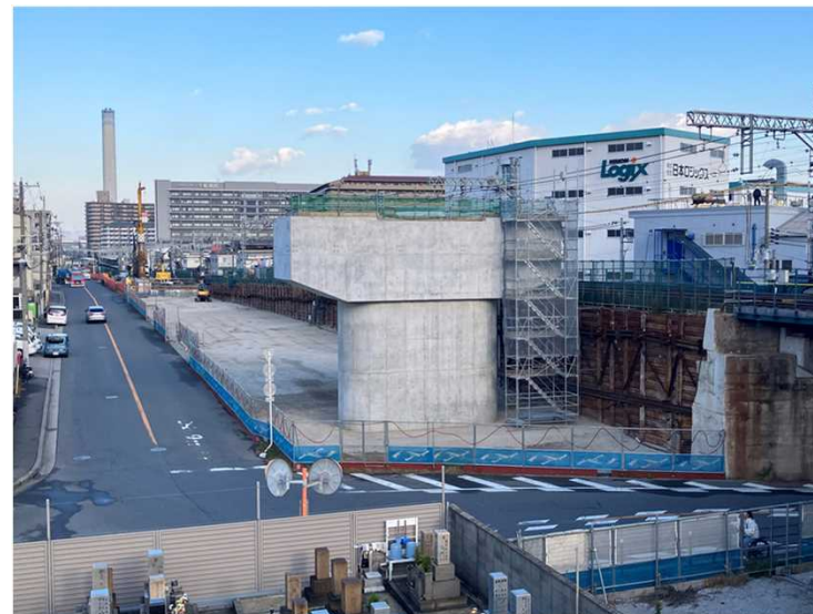
④ P50梁構築工（梁構築状況）
