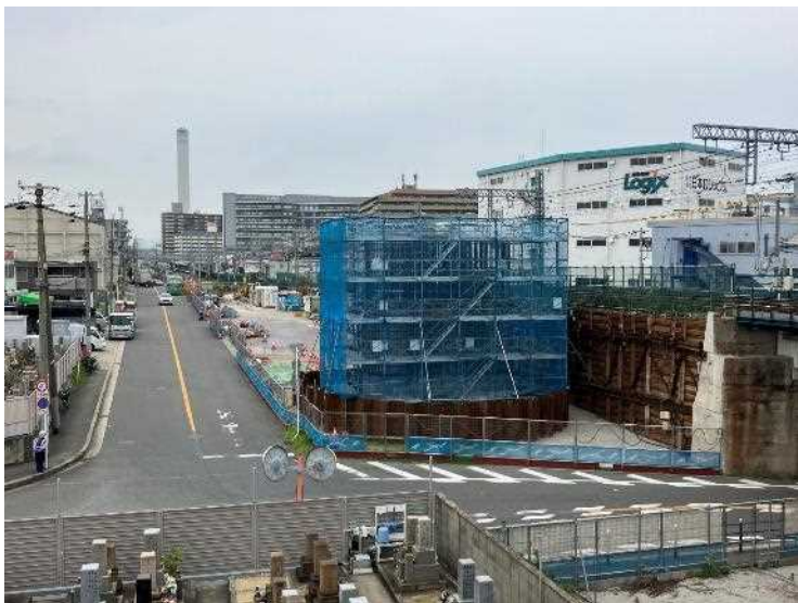
① P46ニューマチックケトン基礎工（柱構築状況）
