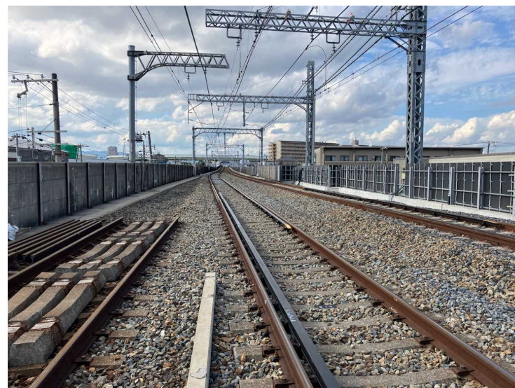
②仮線構築工（仮下り線切替）
