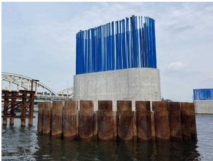
③P58場所打杭基礎工（梁構築完了）
