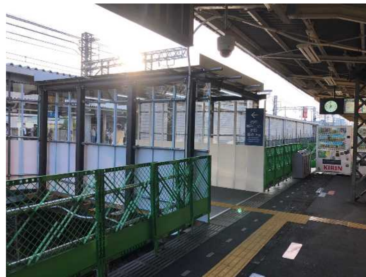
②仮駅舎構築工（仮福駅下りホーム供用開始）
