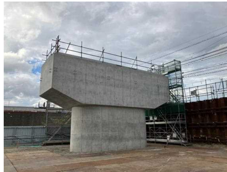
②P57オープンケーソン基礎工（梁構築完了）
