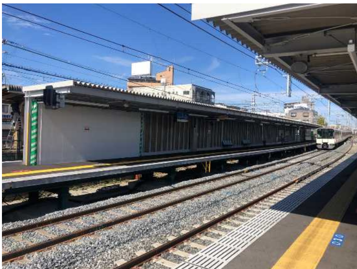
③仮線構築工（仮下り線切替）
