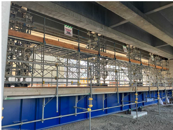
①仮下り線準備工（既設桁補強）
