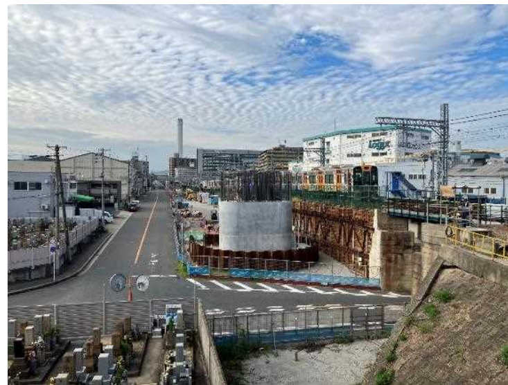
② P46ニューマチックケトン基礎工（柱構築完了）
