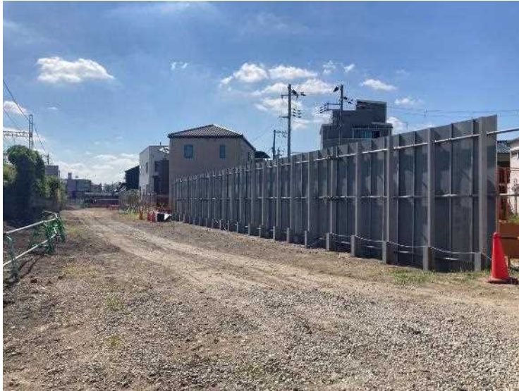
①保安柵設置工
