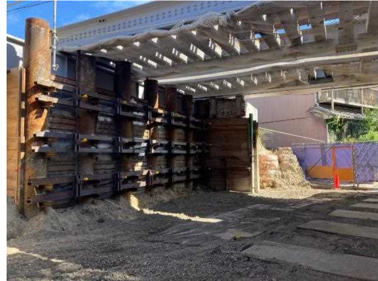
②既設橋台撤去工
