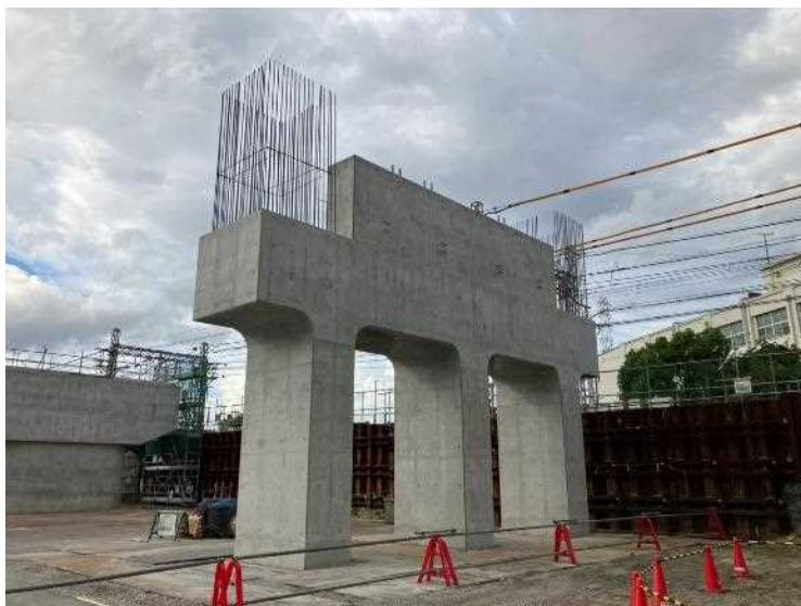
③P58場所打杭基礎工（梁構築完了）
