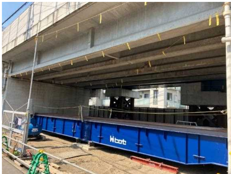
③仮線敷設工（仮下り線踏切設置）
