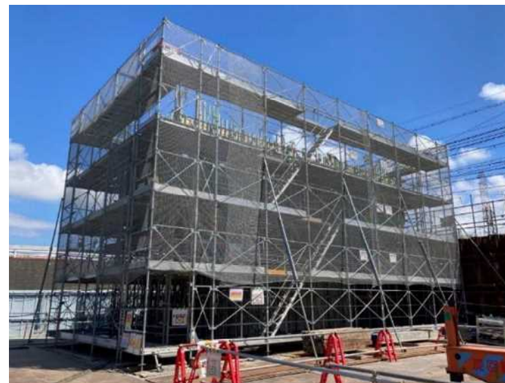
② P57オープンケーソン基礎工（梁構築）
