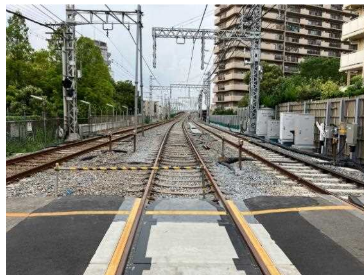
②仮線敷設工（仮下り線）
