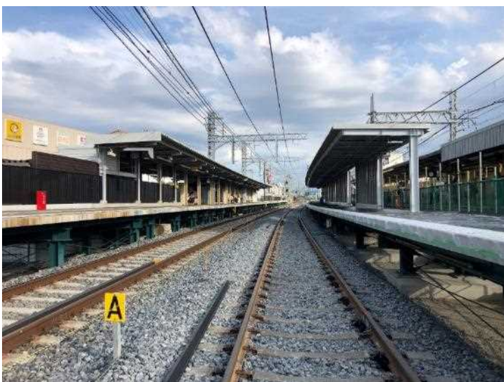
③仮線敷設工（仮下り線）
