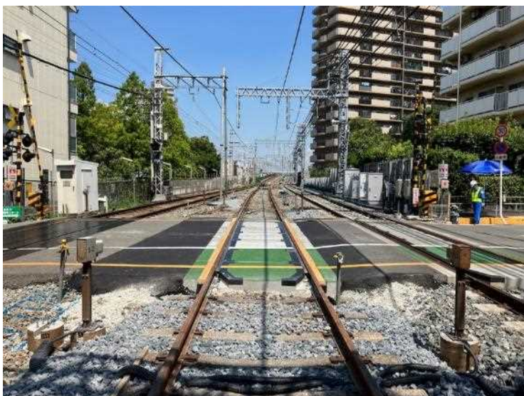
③仮線敷設工（仮下り線踏切設置）
