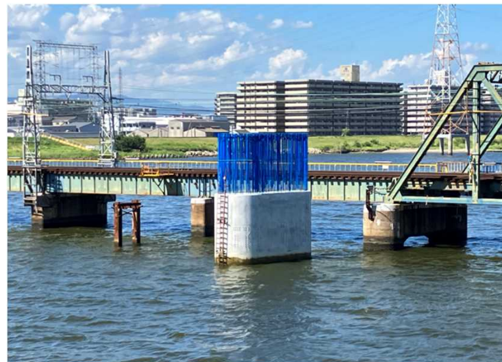
④P50鋼管矢板井筒基礎工（柱構築完了）
