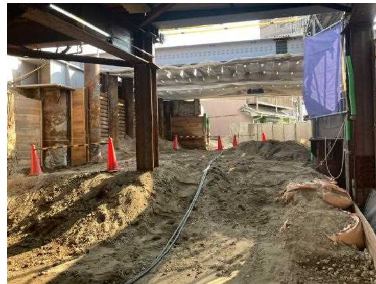
②既設橋台撤去工
