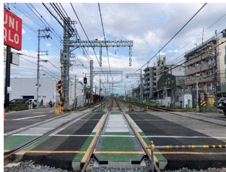
④仮線敷設工（仮下り線踏切設置）
