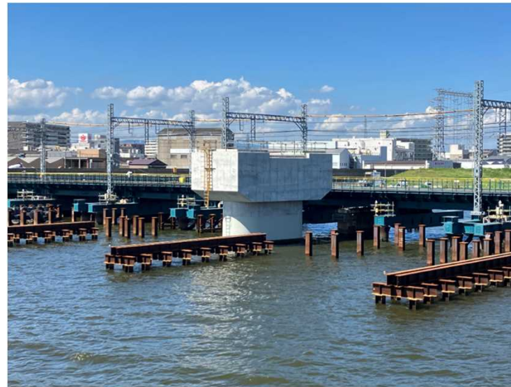
④P50鋼管矢板井筒基礎工（柱構築完了）
