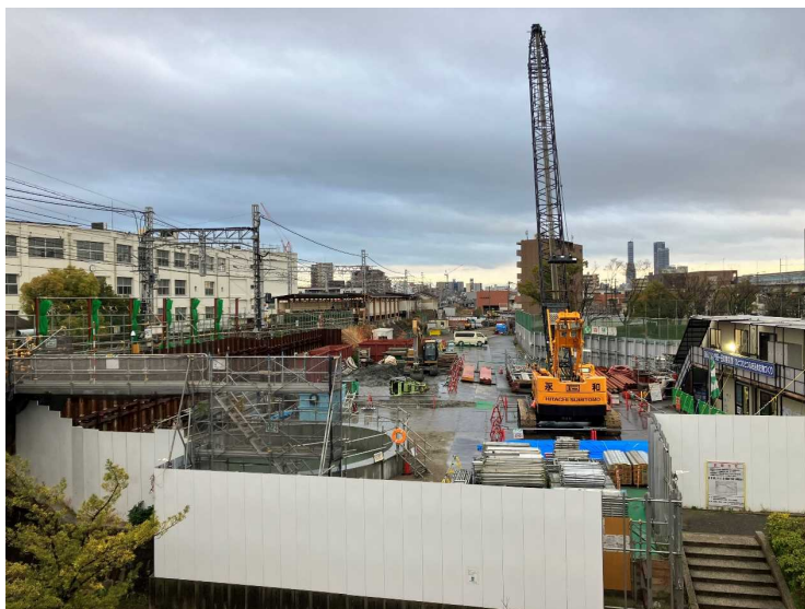
③ P57オープンケーソン基礎工（水中コンクリート打設）
