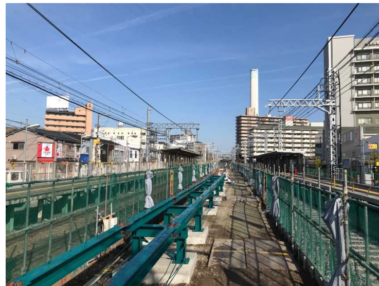
②仮駅舎構築工（ホーム受桁架設）
