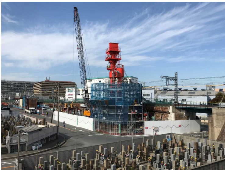
③P48鋼管矢板井筒基礎工（梁型枠解体）
