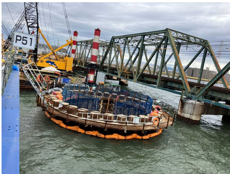
③ P57オープンケーソン基礎工（水中コンクリート打設）
