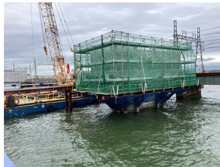
② P55鋼管矢板井筒基礎工（梁構築）
