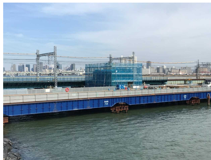
④P50鋼管矢板井筒基礎工（頂版鉄筋組立）
