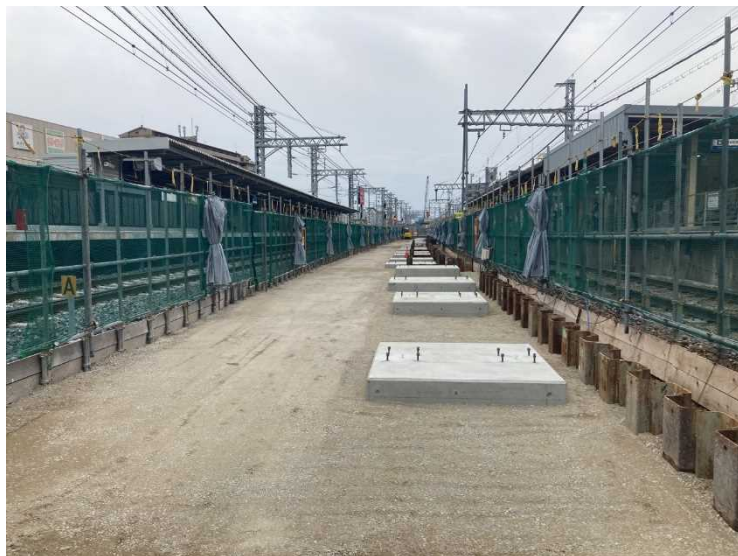
①仮駅舎構築工（ホーム基礎構築）
