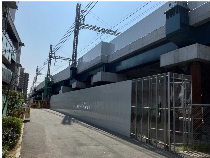
①側道復旧工（淀川通り側）
