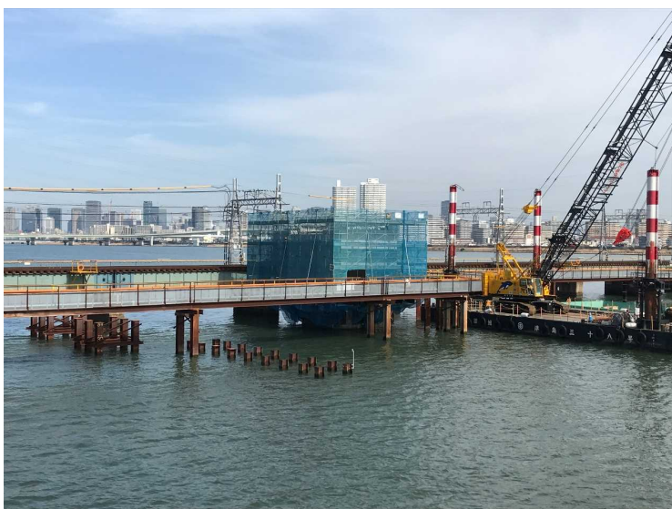
③P48鋼管矢板井筒基礎工（梁型枠解体）
