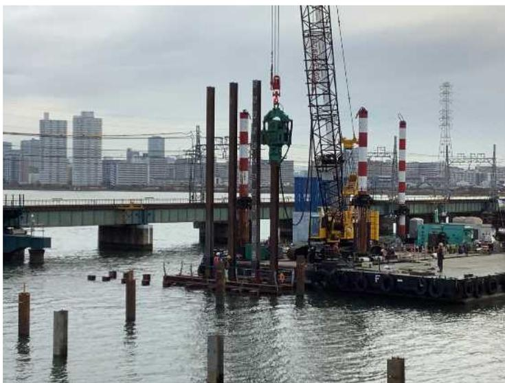
④P50鋼管矢板井筒基礎工（鋼管矢板圧入）
