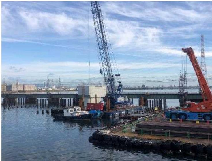
② P51鋼管矢板井筒基礎工（導杭打設）
