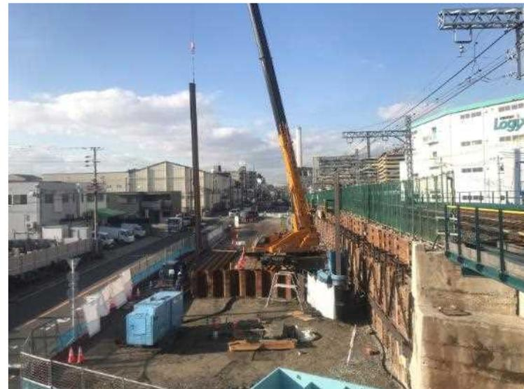
③栈橋支持杭打設工
