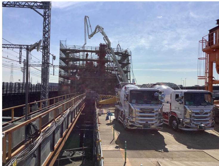
②ニューマチックケーソン基礎工（側壁構築完了）
