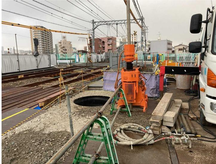
②工事桁支持杭打設・土留鋼管杭打設工
