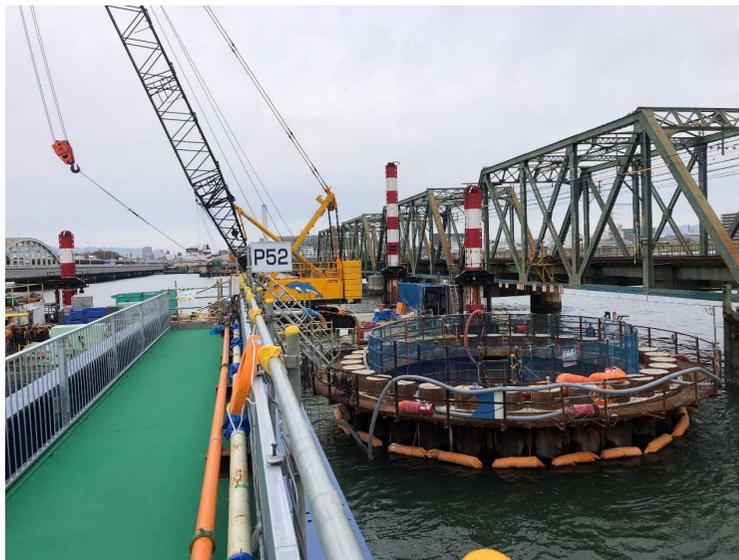
②鋼管矢板井筒基礎工（頂版構築）
