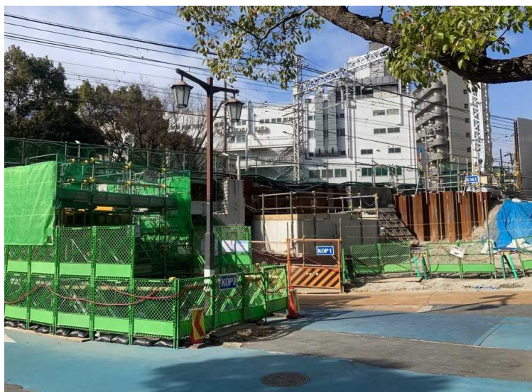
③仮線構築工（橋脚構築工）
