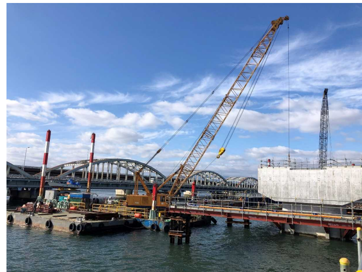
②鋼管矢板井筒基礎工（躯体構築）
