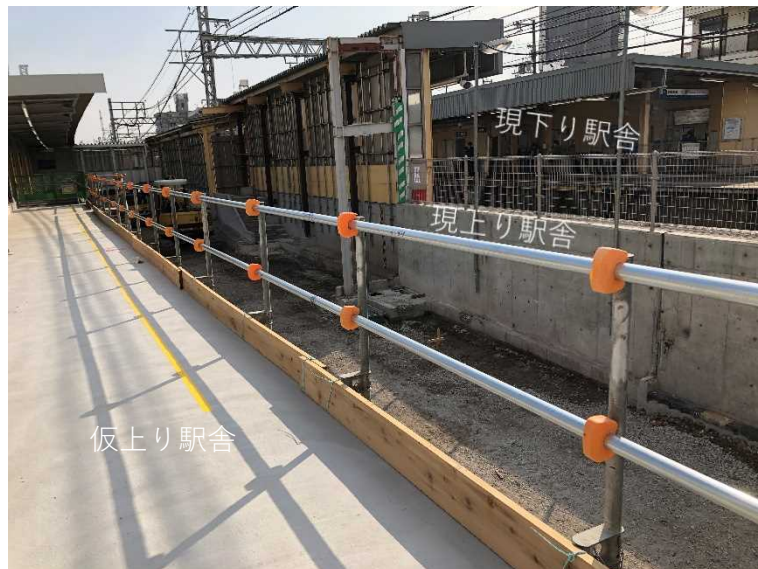
①仮駅舎構築工
