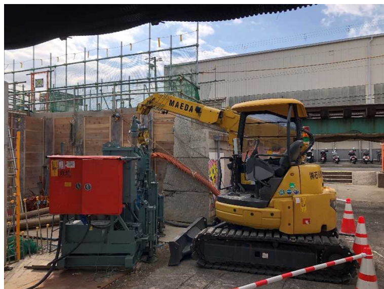
③仮線構築工（基礎杭工）
