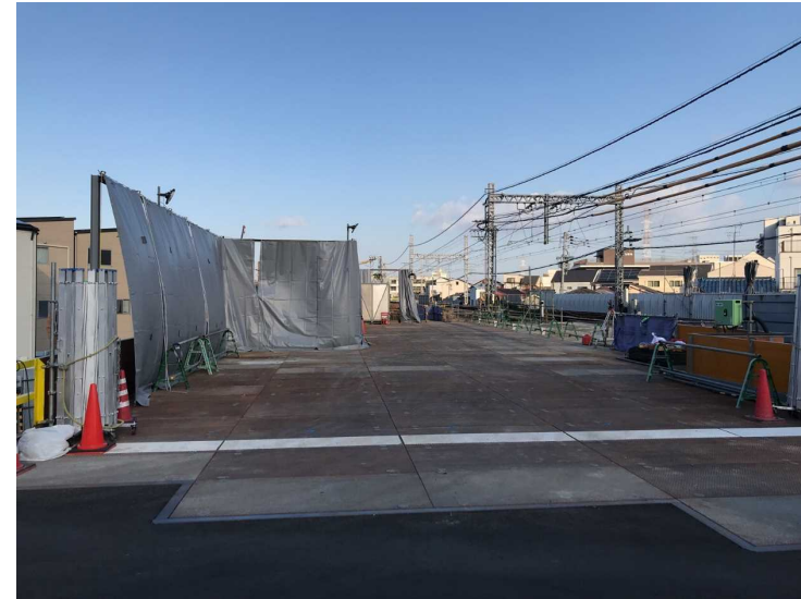
②仮設構台設置工
