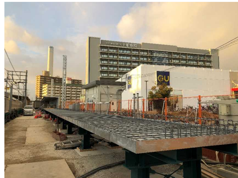
②仮駅舎構築工
