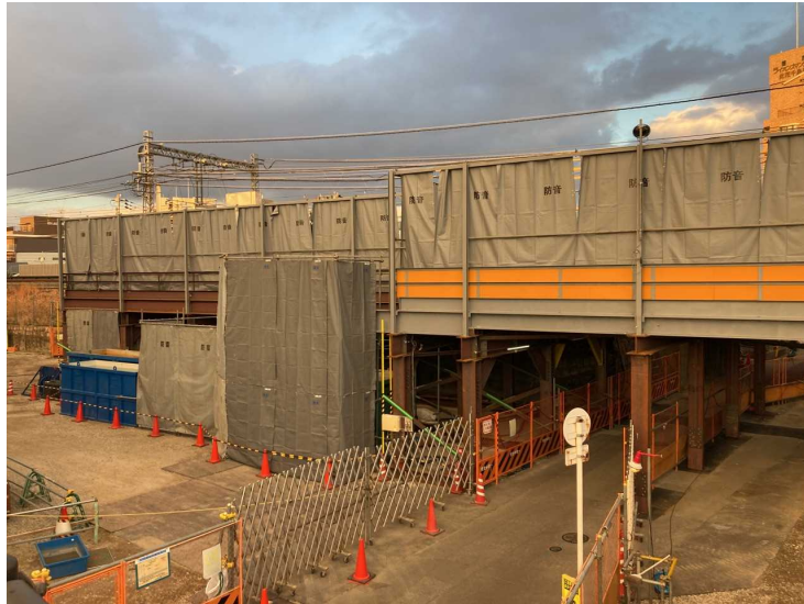
①仮設構台設置工
