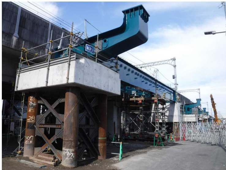
①仮線桁架設工
