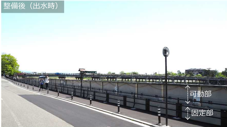
整備後（出水時）
