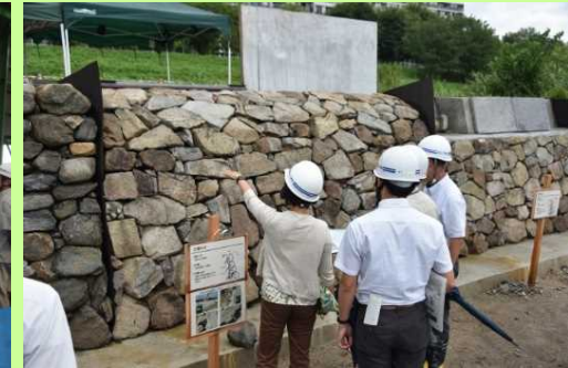
R1. 8. 28 試験施工視察 (学識者)
