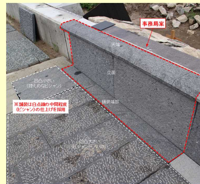
可動式止水壁の意匠案(試験施工状況)
