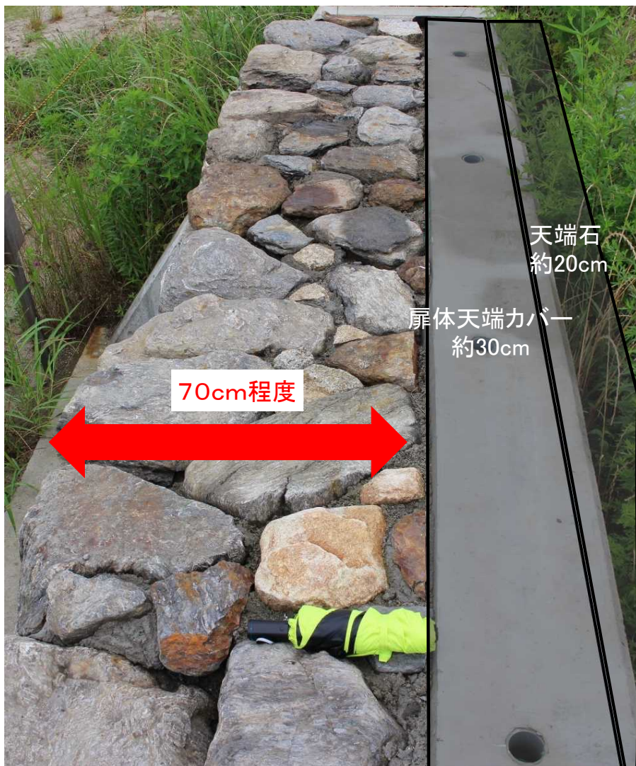
天端まで練石積みの試験施工
