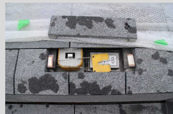
油圧シリンダ部の天端石の設置状況
