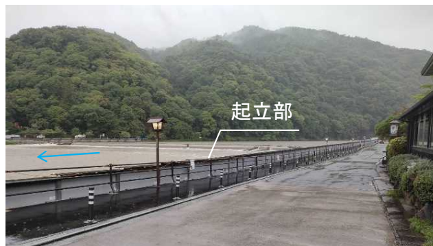
現地状況(起立部)
