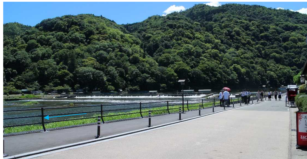
【平常時】道路側から上流を望む(令和3年7月19日撮影)
