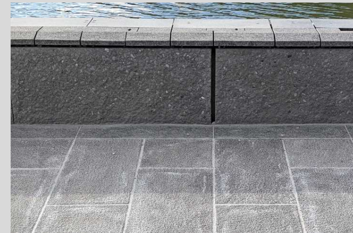
石畳と意匠パネルの設置状況
