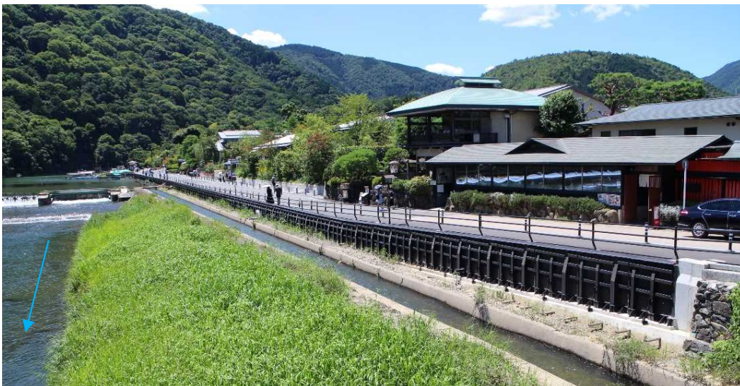
【平常時】川側から上流を望む(令和3年7月19日撮影)
