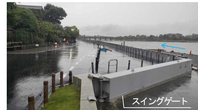
現地状況(スイングゲート)
