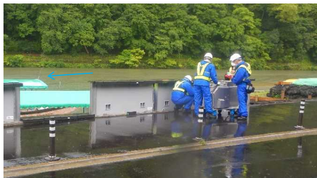
油圧シリンダーによる押し上げ操作 (操作は京都市が実施)
