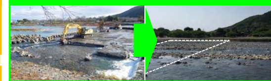
6号井堰撤去 (H29完了)
