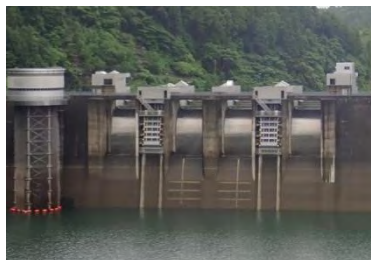
洪水貯留開始直後の貯水池の状況 (7月5日8時頃)
