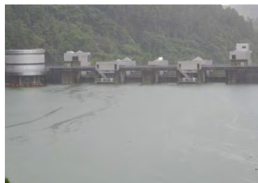
洪水時最高水位に近づく貯水池の状況 (7月5日10時頃)
