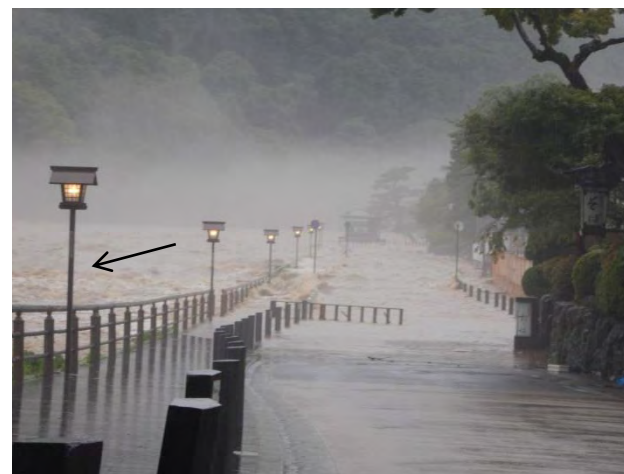
左岸道路浸水状況 渡月橋北詰より撮影 (平成30年7月豪雨)
