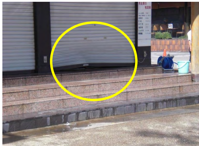
(H25.9月台風18号) 漂流物により損傷した店舗のシャッター
