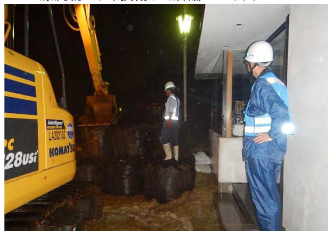
(H30.7月豪雨) 出水の都度、重機による事前の土のう設置撤去が必要
