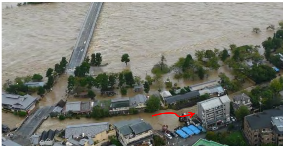
平成25年台風18号時の派川の固定堰による堰上げ
